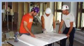
Les équipes sont à pied d'œuvre pour la construction du Centre
